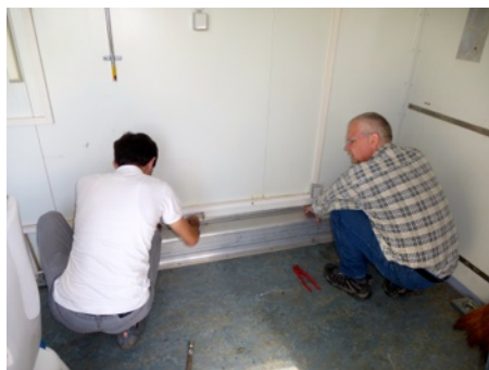
Christof Weller und armenischer Mitarbeiter bei letzten Installationen
